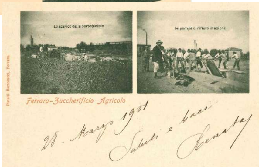
Lo scarico della barbabietola, la pompa di rifiuto in azione, Zuccherificio Agricolo, Ferrara, 1901
